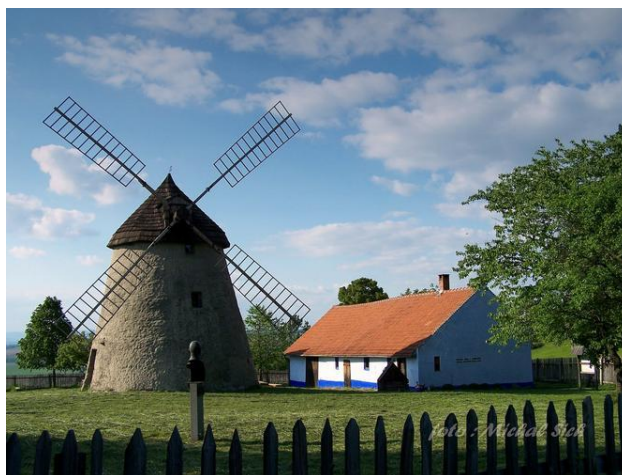
Obr. č. 61: Větrný mlýn v Kuželově
